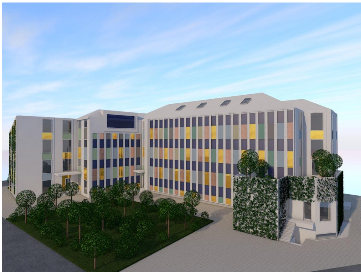
Foto 13 și 14. Proiect Reparația capitală și schimb de destinație din Școala postliceală sanitară în secție Recuperare, medicină fizică și balneologie și extindere Ambulatoriu
